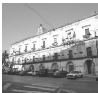
Palazzo San Domenico, sede del Comune (sz)
